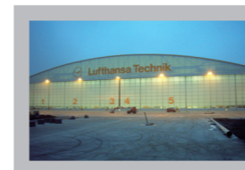
Frankfurter Flughafen CCT Halle
