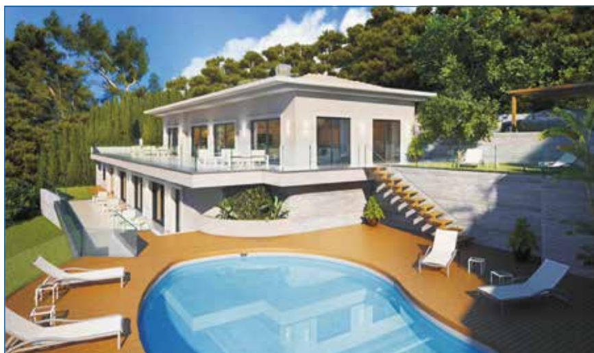
Eine private Villa in Eze (Südfrankreich): Steuerung der Heizungs-, Lüftungs- und Klimatechnik erfolgt über KNX, konfiguriert ausschließlich mittels ETS
