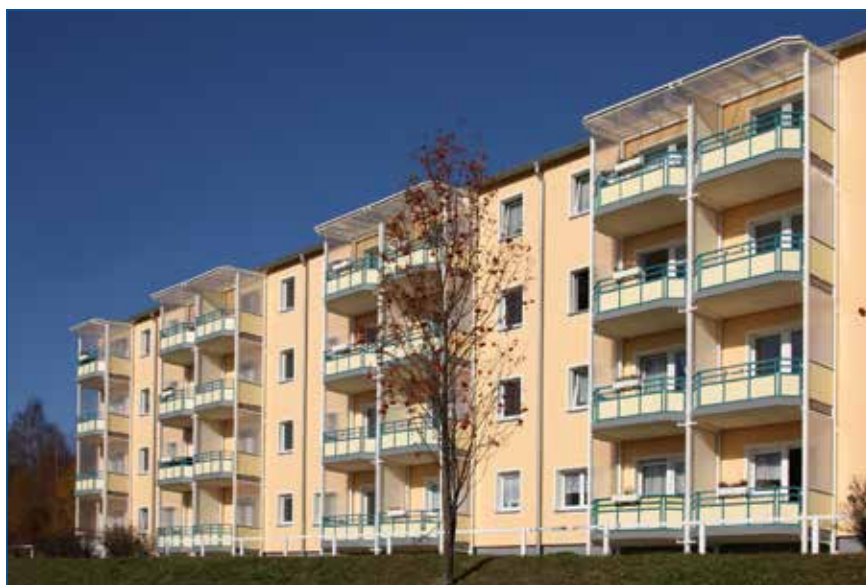
Mit KNX Technik sanierter Gebäudekomplex in Schwarzenberg
