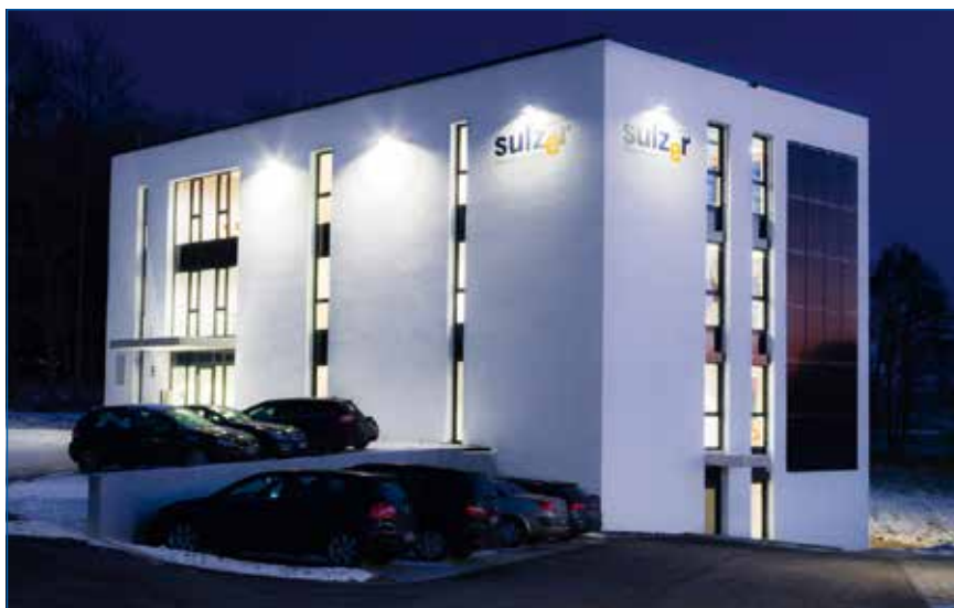
Optimierter Stromverbrauch, dank effektiver Planung von intelligenter Lichtregelung
