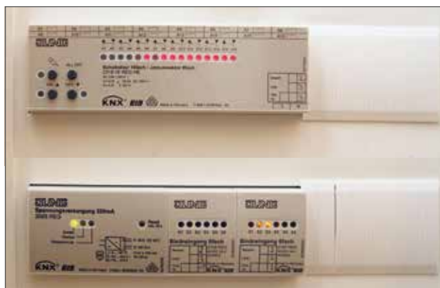
Verteilung – Schaltaktor 16fach / Jalousieaktor 8fach und Spannungsversorgung 320 mA
