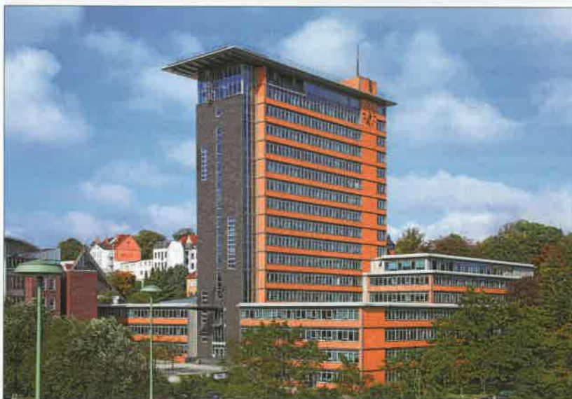
Das Flensburger Rathaus war eines der ersten städtischen Gebäude, das Mitte der 90er Jahre im Zuge einer Sanierung mit KNX ausgestattet wurde. Foto: Stadt Flensburg
