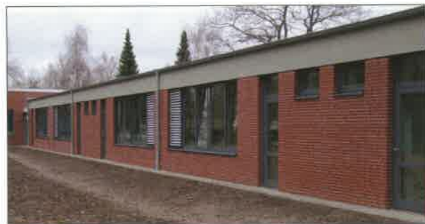
Ein Teil des Neubaus der Grundschule Engelsby: Die Türen (Haupteingänge und Fluchttüren) werden mit Magnet- und Riegelkontakt überwacht und via KNX in der Gebäudevisualisierung dargestellt. Foto: Stadt Flensburg
